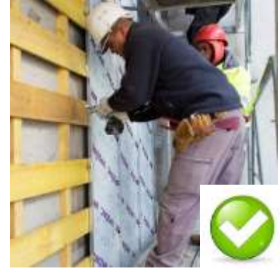
Düz yapıların büyük panel uygulaması altındaki kaplama tahtası aralıkları daha geniş bırakılmıştır.
