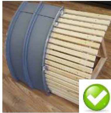
Kavisli yapıların uygulaması altındaki kaplama tahtası aralıkları daha sık bırakılmıştır.
