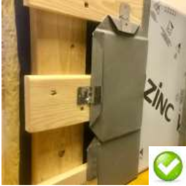
Standartlara uygun 2 cm havalandırma kesiti
