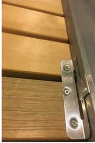
Hareketli klipsler ahşap alt yapıdan bağımsız çalışır.
