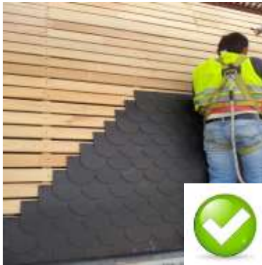
Küçük elementler, VMZ Soletos uygulaması altındaki kaplama tahtası aralıkları daha sık bırakılmıştır.
