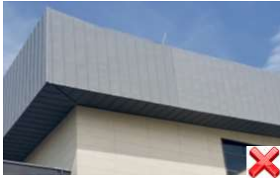
Aynı cephede "farklı" lot'lardan üretim yapılmış paneller
