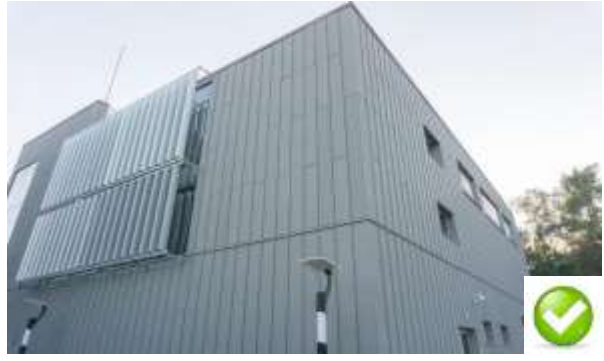
Farklı cephelerde aynı lot'lardan üretim yapılmış paneller
